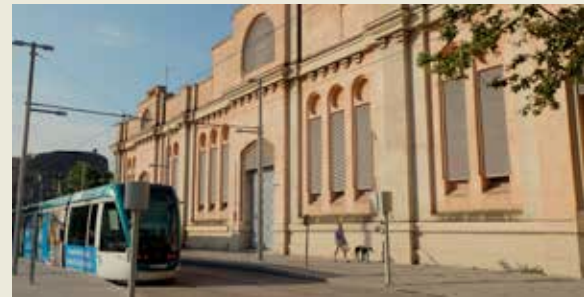
Façana de la Unitat Muntada de la Guàrdia Urbana de Barcelona. Foto: Latitudes Fachada de la Unidad Montada de la Guardia Urbana de Barcelona. Foto: Latitudes Façade of the Mounted Unit of the Barcelona City Police. Photo: Latitudes
